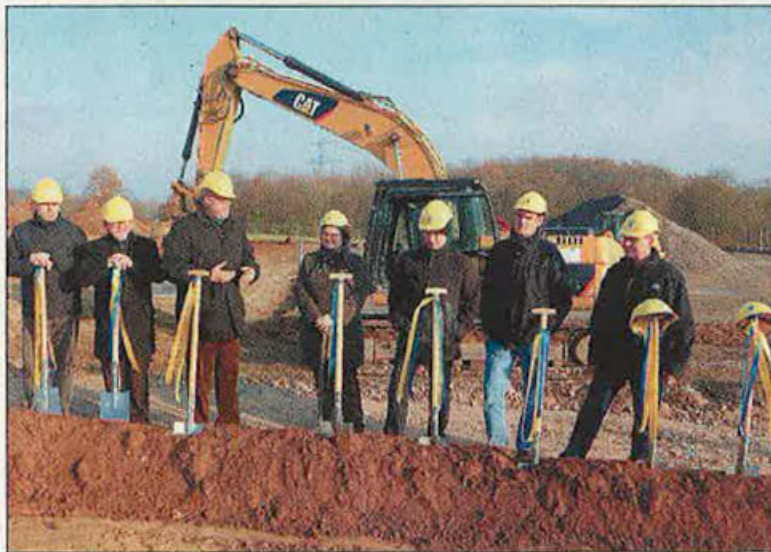
Spatenstich für ein Großprojekt: Am Psychiatrischen Zentrum Nordbaden entsteht eine Küche, die über 4000 Essen am Tag ausgeben soll. Foto: Pfeifer
